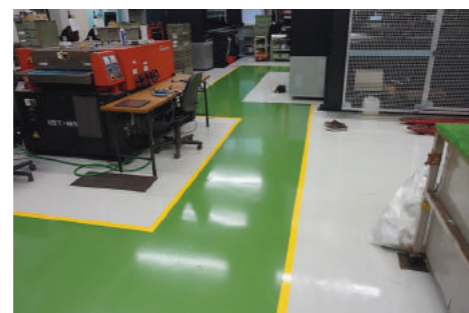
工場・安全通路 施工例
