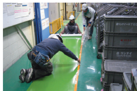
工場・安全通路 施工風景
