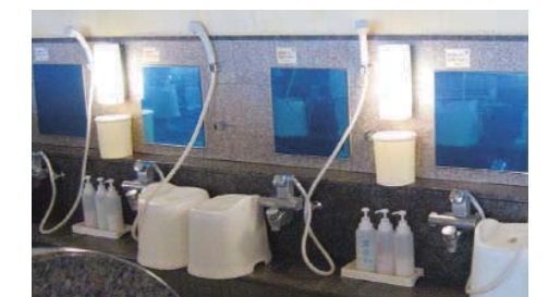
温浴施設 施工例
