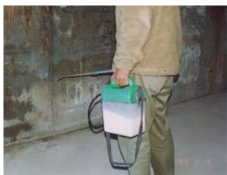
コンクリート壁
