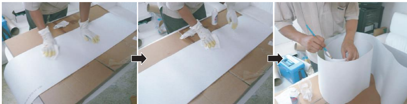
「カビ守護神」コーティング剤にてよく塗り込みます。 → 裏面も同じようにコーティング。出来れば2~3度繰り返して下さい。 → こぐちのところもハケ等でよく塗っておきます。
