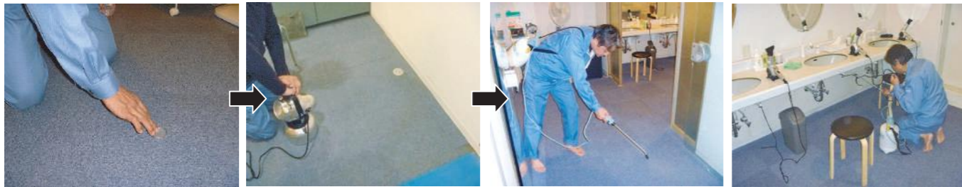
フロアカーペットの菌採取 → 守護神で、除菌消臭施工 → カビ守護神で、防臭・防カビ処理
