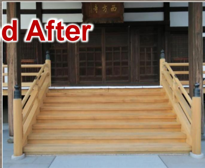
風雪に耐え変色した木材は情緒があり風格を感じます。しかし、汚れは腐朽菌・カビ・藻等の温床で、放置すると腐敗により強度が大きく低下し大規模な修繕が必要となります。エア—鉋工法は、薬剤（灰汁洗い）や研磨などの従来工法に比べ、工期が短く安価な工法です。化学薬品で木材を傷めない、天然素材を使用し環境に配慮した安心・安全な工法です。
